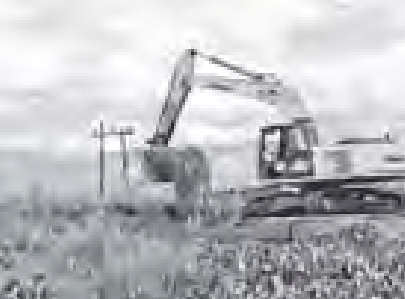
ငါးဖယ်ချောင်းရေလမ်းကြောင်းအတွင်း ကျွန်းများရှိသည့်ရှင်းလင်းခြင်း လုပ်ငန်းဆောင်ရွက်နေစဉ်။
