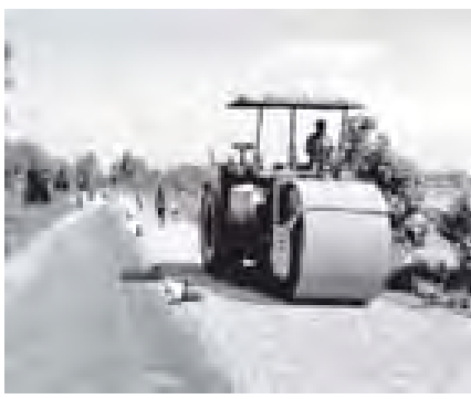
သုံးခွ-သန်လျင် လမ်းပိုင်းကို ကတ္တရာခင်းရန် ဤသို့လမ်းကြိုစက်ကြွမြင့် ဆောင်ရွက်နေပုံ။
