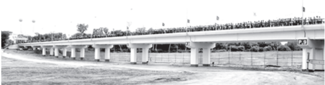
ပခုက္ကူမြို့နယ် ပခုက္ကူ-မုံရွာလမ်းပေါ်ရှိ ရွှေချောင်းတံတားအမှတ်(၁)ကို တွေ့ရစဉ်။
