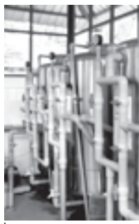
ဂါလန် ၂၀၀၀၀ ခန့် ရေကန်ရှိ ရေသန့်စင်ထုတ်လုပ်မှုစနစ်ကို ဤသို့ တွေ့ရသည်။
