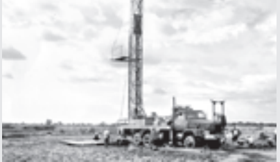
ရေအရင်းအမြစ်အသုံးချရေးဦးစီးဌာန မြေအောက်ရေတူးဖော်မှု ဝန်ထမ်းများ မော်ကွန်း-ဘုရားငါးဆူဒေသတွင် တူးဖော်ရေးကော်မရှင် စက်ရေတွင်းတူးဖော်မှုကို တွေ့ရစဉ်။ (သတင်းစဉ်)
