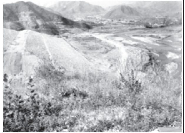
မြို့ကြီး ဆည်တံ တည်ဆောက်မှုမြင်ကွင်းကို ဤသို့ တွေ့ရသည်။
