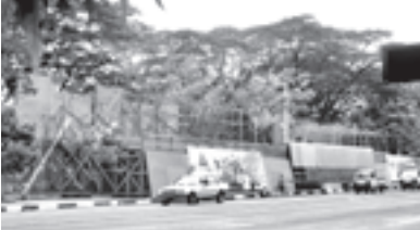
ရန်ကုန်မြို့ ကမ္ဘာ့အေးဘုရားလမ်း ဆီဒီနားဟိုတယ်ရှေ့ ဆောက်လုပ်ဆဲမဏ္ဍပ်တစ်ခုကို တွေ့ရပုံ။
