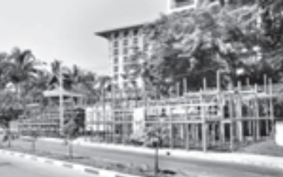
ရန်ကုန်မြို့ ကန်တော်ကြီးပတ်လမ်းတစ်နေရာရှိ ဆောက်လုပ်ဆဲ မဏ္ဍပ်တစ်ခုကို တွေ့ရစဉ်။
