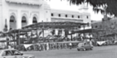
ရန်ကုန်မြို့တော်ဝန် မဟာသင်္ကြန်မဏ္ဍပ် ဆောက်လုပ်မှုမြင်ကွင်းကို ဧပြီ ၂ ရက်က တွေ့ရစဉ်။ (ဓာတ်ပုံတင်ဇိုး-မြန်မာ့အလင်း)
