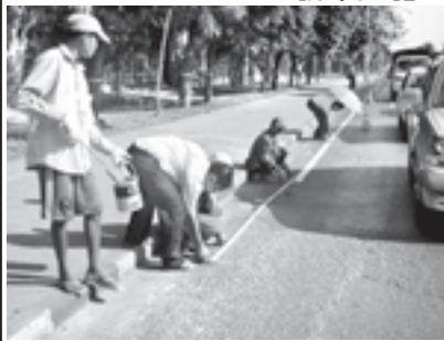
လှည်းတန်းခုံးကျော်တံတားတည်ဆောက်ရန် ပထမပြင်ဆင်မှုမြင်ကွင်း။
