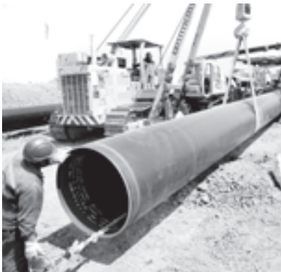
ဒုတိယသမ္မတ သီဟသူရ ဦးတင်အောင်မြင်ဦး စကုန်ယံမြေအတွင်း သဘာဝဓာတ်ငွေ့နှင့် ရေနံပိုက်လိုင်းသွယ်တန်းခြင်းလုပ်ငန်း ဆောင်ရွက်နေမှုကို ကြည့်ရှုစစ်ဆေးစဉ်။
