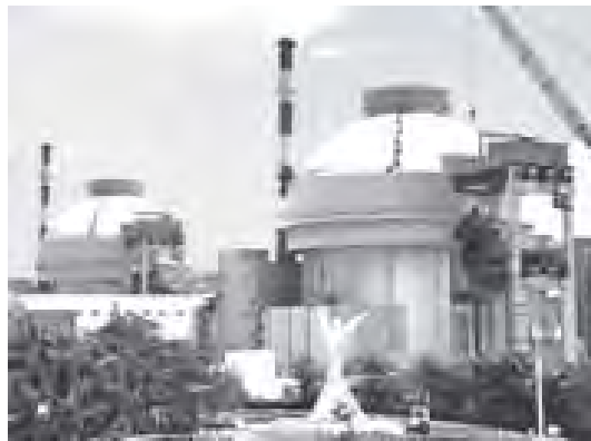
အိန္ဒိယနိုင်ငံ တောင်ပိုင်း တနင်္သာရီ ပြည်နယ်၌ ရုရှားနိုင်ငံက တည်ဆောက် ပေးခဲ့သော ကီနိုကူလမ် ဓာတ်အားပေးစက်ရုံကို တွေ့ရစဉ်။ (ဓာတ်ပုံ-အင်တာနက်)
