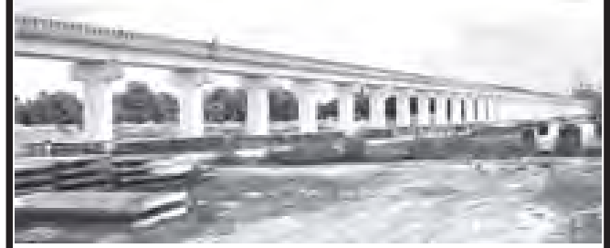
ဧရာဝတီတံတား (ပခုက္ကူ)၏ မီးရထားလမ်း တံတားတည်ဆောက်ပြီးစီးနေမှုကို ဤသို့တွေ့ရသည်။
