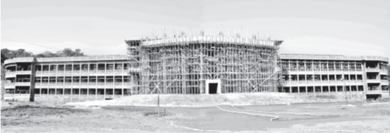
ကွန်ပျူတာတက္ကသိုလ်(ကလေး)ပင်မသုံးထပ်ကျောင်းဆောင်သစ် တည်ဆောက်နေမှုကို တွေ့ရစဉ်။
