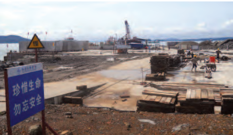
မဒေးကျွန်းရှိ ရေနံ သိုလှောင်ကန် တည်ဆောက်ရာ နေရာ
