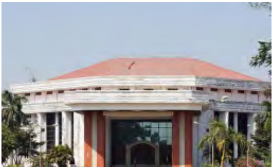
ရန်ကုန်တိုင်းအတွင်းရှိဒဂုံတက္ကသိုလ်၏ပင်မအဆောက်အဦးအားတွေ့မြင်ရစဉ်
