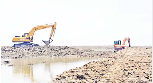
ရခိုင်ပြည်နယ် မြောက်ဦးမြို့နယ် ကုလားပုန်း ကျွန်းပတ်တာ မုန်တိုင်းဒဏ်ကြောင့်ကျိုးပေါက်ခဲ့မှုကို ပြန်လည်ပြုပြင်ရေးလုပ်ငန်းများ ဆောင်ရွက်နေစဉ်။
