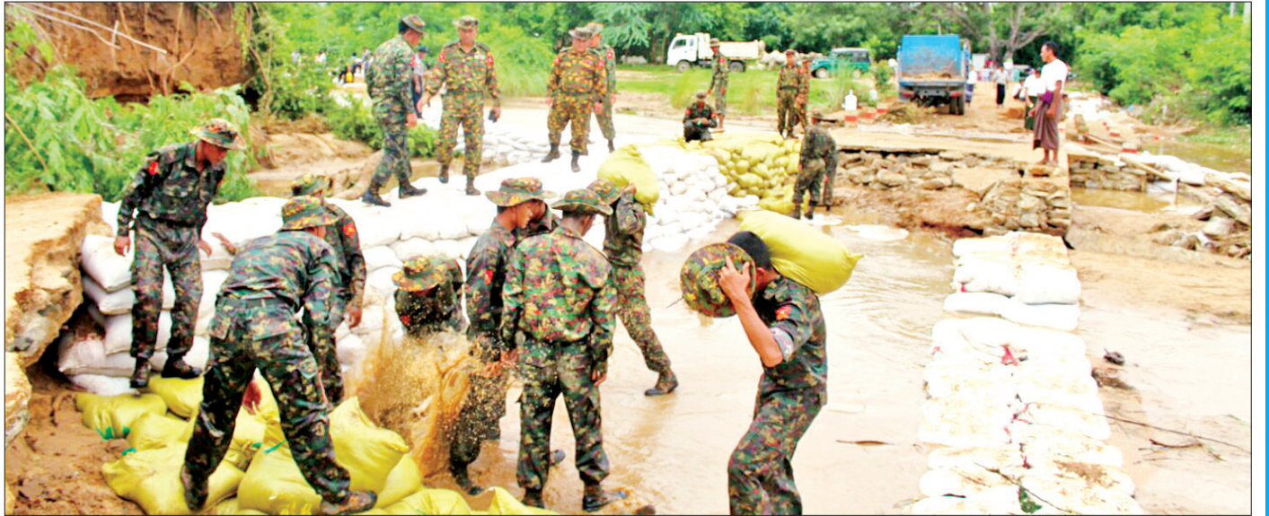
၂၀၁၉ ခုနှစ် မေလက စစ်ကိုင်းတိုင်းဒေသကြီး အရာတော်မြို့နယ်ရှိ မန်ကျည်းဇောက်ချောင်း ကွန်ကရစ်ရေကျော်တံတား ရေတိုက်စားပျက်စီးမှုအား နယ်မြေခံ တပ်မတော်သားများက သဲအိတ်များချထားခြင်း၊ ပိတ်ဆို့နေသောအမှိုက်များရှင်းလင်းခြင်းလုပ်ငန်းများ ဆောင်ရွက်စဉ်။
