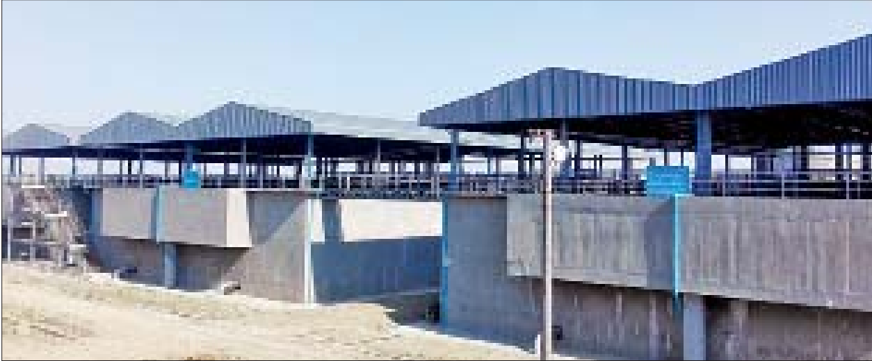
လွန်းပြင်ရေပေးဝေရေးစီမံကိန်းမှ ရေစစ်ကန်များ တည်ဆောက်ထားမှုကို တွေ့ရစဉ်။
