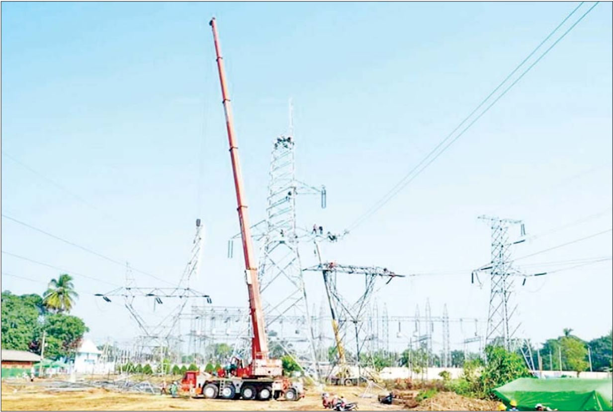
ကံကောင်း (မိတ္ထီလာ) - စပါးကြွယ်(တောင်ငူ) (၅၀၀) ကေဗွီမဟာဓာတ်အားလိုင်း တည်ဆောက်နေမှုကို တွေ့ရစဉ်။
