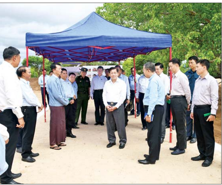
မင်္ဂလာကန်အမှတ်(၃) ပြန်လည်ပြုပြင်ဆောင်ရွက်နေမှုအခြေအနေများကို ကြည့်ရှုစစ်ဆေးစဉ်။
