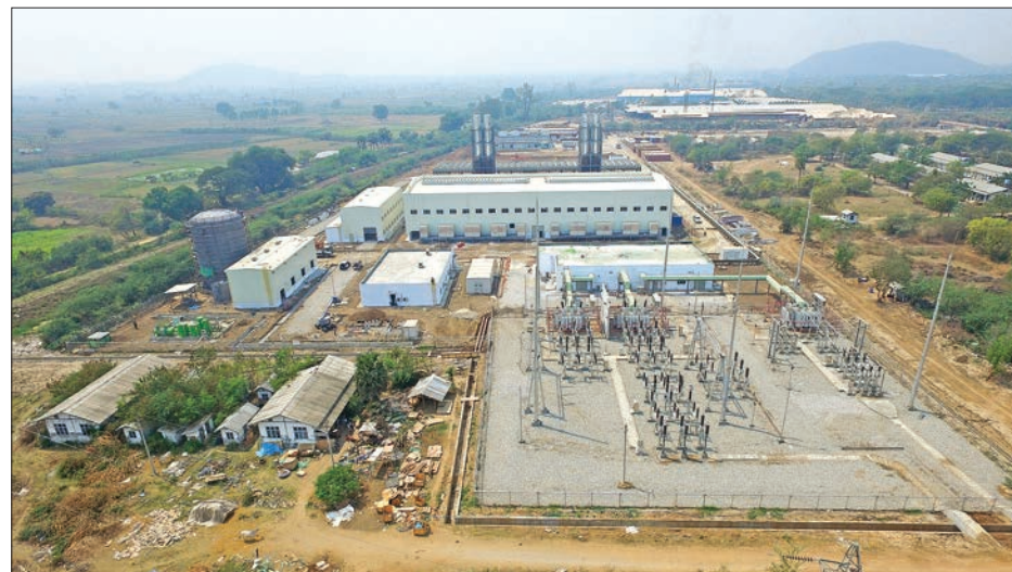
Kyaukse Thermal Power Plant.
