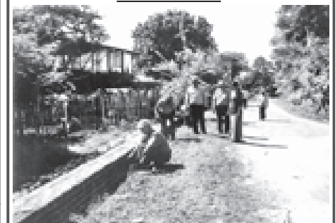
သပိတ်ကျင်းမြို့နယ် စည်ပင်သာယာရေးအဖွဲ့က ပြုသောယာယုပေးလုပ်ငန်းများ အချိန်အတန်ဖြင့်တင် ဆောင်ရွက်လျက်ရှိရာ မြို့အဝင် လမ်းဘေး၊ ယာ ပလက်မောင်းကပ်တံ၊ ပြုလုပ်ခြင်းလုပ်ငန်းကို အငယ်တန်းအင်ဂျင်နီယာ(၂) ဒေါ်ထွေးစန္ဒာ တာဝန်ယူဆောင်ရွက်နေမှုအား အမှုဆောင်အရာရှိ ဦးအောင်ကျော်ဝင်း ကွင်းဆင်းကြည့်ရှုဆောင်ရွက်စဉ်။ (မြို့နယ်စည်ပင်)
