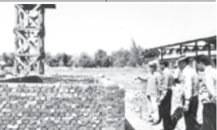
ရန်ကုန်တိုင်းဒေသကြီး စည်ပင်သာယာရေးအဖွဲ့ ညွှန်ကြားရေးမှူးချုပ် ဦးအောင်ကျော်ဦးစီး ဝန်ထမ်းများနှင့် စည်ပင်သာယာရေးအဖွဲ့မှ ၂၀၁၀-၂၀၁၁ ဘဏ္ဍာရေးနှစ် အဖွဲ့ရန်ပုံငွေဖြင့် ဆောင်ရွက်ထားရှိသော ဗြဟ္မစရေမင်းသတ်ရောက်တည်ဆောက်နေရာရှိ ကျင်းဆင်းစစ်ဆေးရာ အထူးဆောင်အရာရှိ ဦးဆန်းအောင်နှင့် တာဝန်ခံအင်ဂျင်နီယာ ဦးမျိုးမင်းတို့ ရှင်းလင်းတင်ပြစဉ်။ (မြို့နယ်စည်ပင်)
