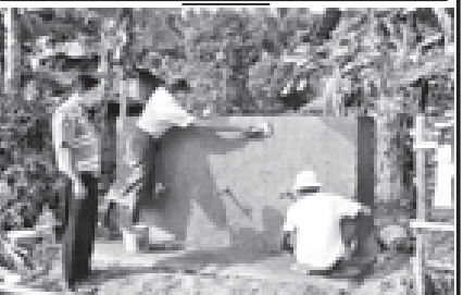
မုဆယ်မြို့နယ် စည်ပင်သာယာရေးအဖွဲ့က ၂၀၁၀-၂၀၁၁ ဘဏ္ဍာရေးနှစ် ရန်ပုံငွေဖြင့် ပြုလုပ်သော ကောင်းခံကျေးရွာ ဝါလန် ၁၀၀၀ ဆုံ အုတ်ရေကန် တည်ဆောက်ခြင်းလုပ်ငန်းကို အင်ဂျင်နီယာမှူး ဦးကျုံးလွန်ဦး၊ ကြီးကြပ် စစ်ဆေးစဉ်၊ (မြို့နယ်စည်ပင်)
