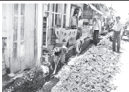
ထားဝယ်မြို့နယ် စည်ပင်သာယာရေးအဖွဲ့မှ မြို့တွင်းလမ်းများ ရေစီးရေလွှာကောင်းမွန်ရေးအတွက် ထားဝယ်မြို့ ဦးကျော်ရင်လမ်း ရေမြောင်း တူးဖော်ခြင်းလုပ်ငန်းကို အင်ဂျင်နီယာမှူး ဦးထင်လင်းကော် မြို့ကြည်ဆောင်ရွက်စဉ်။ (မြို့နယ်စည်ပင်)
