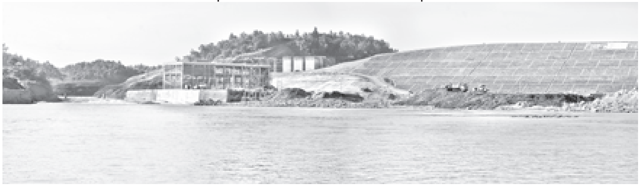
မုန်းချောင်းအတွင်းမှ တွေ့မြင်ရသော ပင်မတပ်နှင့် တည် ဆောက်ဆဲ Power House
