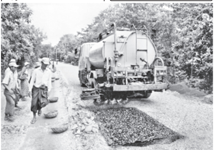
ပုသိမ်-မုံရွာလမ်းမကြီး အဆင့်မြှင့်တင် ဖောက်လုပ်ရေးစီမံကိန်း အပိုင်း(၂) လမ်းအထူးအဖွဲ့(၇)၏ လုပ်ကိုင်တွင် ဝင်ကြံမြှင့် ကမ္ဘာ့ ခင်းနေစဉ်။
