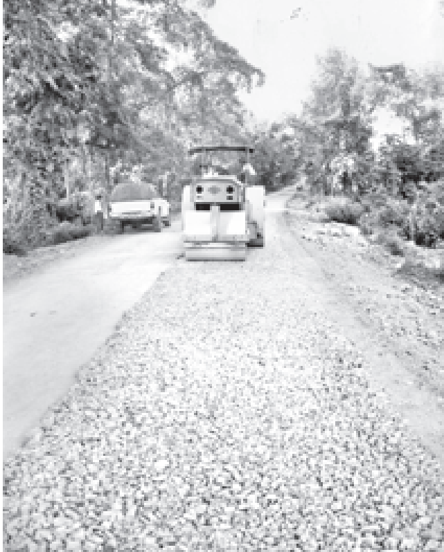
ပုသိမ်-မုံရွာလမ်းမကြီး မောက်လုပ်ရေးစီမံကိန်းတွင် ကတ္တရာလမ်းအဖြစ် အဆင့်မြှင့်တင်ရန် ထပ်ပို့လွှာကျောက်များခင်း၍ လမ်းကြိတ်စက်ကြီးများဖြင့် ကြိတ်ပေးနေစဉ်။
