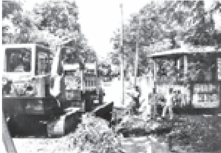
ကသာမြို့နယ် စည်ပင်သာယာရေးအဖွဲ့မှ နတ်ရေတွင်းလမ်း ကျောက်ဆရာ လမ်း(ကျေးလက်) ခင်းခြင်းလုပ်ငန်း အရည် ၇၆၀၀ မေ၊ အကျယ် ၁၂ ပေအား အလယ်တန်းအင်ဂျင်နီယာ(၂) ဦးဖြင့်သန့်၊ တာဝန်ယူဆောင်ရွက်လျက်ရှိရာ ကျောက်ဆေးတန်းတန်းများအား အမှုဆောင်အရာရှိ ဦးကျန်းထွန်းနှင့် တာဝန်ခံ အင်ဂျင်နီယာ ဦးဇော်ဇော်ဖြင့် တွင်းဆင်းကြည့်ရှုဆောင်ရွက်စဉ်။ (မြို့နယ်စည်ပင်)
