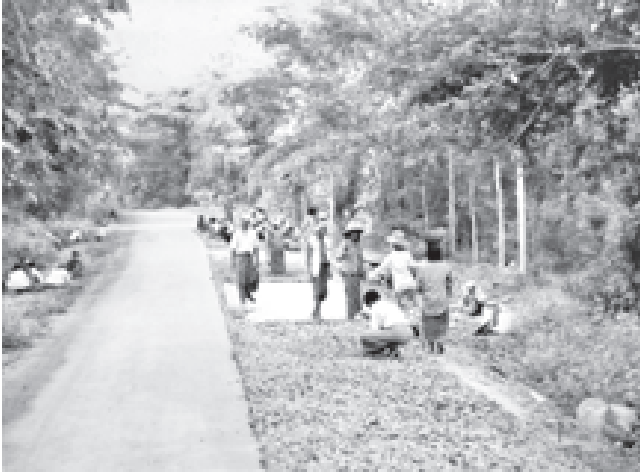
ပုသိမ်-မုံရွာလမ်းမကြီး အဆင့်မြှင့်တင် မောက်လုပ်ရေးစီမံကိန်း အပိုင်း(၂) ဥသွပ်ပင်-ကလွန်းမအပိုင်းတွင် လမ်းအထူးအဖွဲ့များ၏ ကျောက်ခင်းလုပ်ငန်း ဆောင်ရွက်နေကြပုံကို ဤသို့တွေ့ခဲ့ရသည်။
