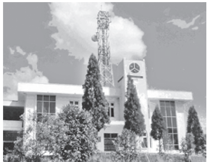
ရှမ်းပြည်နယ် (မြောက်ပိုင်း) မူဆယ်မြို့ အောက်တိုအိတ်ချိန်း အဆောက်အအုံကို တွေ့ရစဉ်။
