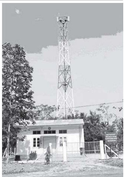
တနင်္သာရီတိုင်းဒေသကြီး ကော့သောင်းမြို့ (၇)မိုင်ရှိ GSM စခန်း အဆောက်အအုံကို တွေ့ရစဉ်။
