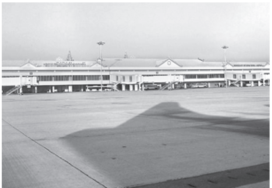
နိုင်ငံတကာအဆင့်မီ မန္တလေးအပြည်ပြည်ဆိုင်ရာလေဆိပ် အဆောက်အအုံကို တွေ့ရစဉ်။
