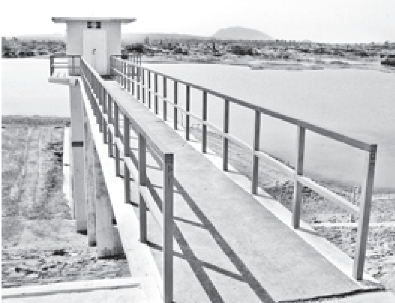
မကွေးတိုင်းဒေသကြီးတွင် နိုင်ငံတော်က ဆည်တစ်ခုမျှ တည်ဆောက်ပေးလျက်ရှိရာ ရေစံကြိုမြို့နယ်အတွင်း တည်ဆောက်ထားသည့် ငွေ့ချိုရေလျှောင်တံနှင့် ရေထိန်းမျှော်စင်ကို တွေ့ရစဉ်။
