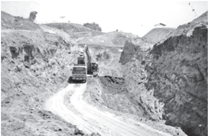
မုက္ခာရေလောင်တစ် တည်ဆောက်ရေးစီမံကိန်း၌ မြေကြီးလုပ်ငန်းများကို အင်တိုက်အားတိုက်ဆောင်ရွက်ကြစဉ်။
