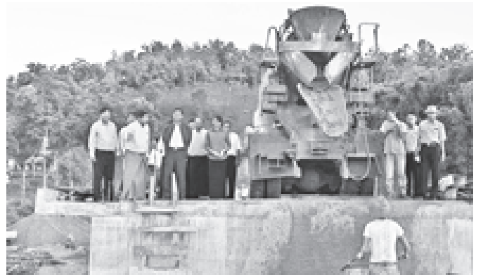
ဆောက်လုပ်ရေးဝန်ကြီးဌာန ဝန်ကြီး ဦးခင်မောင်မြင့်၊ ဇွေလေး-လားရှိုး-မုဆယ်လမ်းပေါ်ရှိ သီပေါတံတား တည်ဆောက်နေမှုကို ကြည့်ရှုစစ်ဆေးစဉ်။
