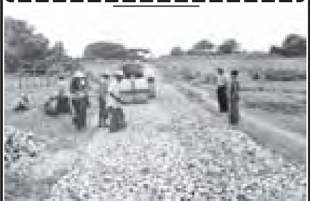
ကနီသလူမြို့နယ် စည်ပင်သာယာရေးအဖွဲ့က ဆောင်ရွက်လျက်ရှိသည့် အထက်(၂)အဝင်လမ်း ကျောက်ချောင်းခြင်း ဆောင်ရွက်စဉ်၊ (မြို့နယ်စည်ပင်)
