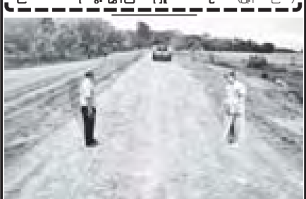
ရခိုင်၊ မြို့နယ် စည်ပင်သာယာရေးအဖွဲ့က ရေဦး-တမာတောလမ်း ကျောက်ချောင်းခြင်းလုပ်ငန်း ဆောင်ရွက်စဉ်၊ (မြို့နယ်စည်ပင်)
