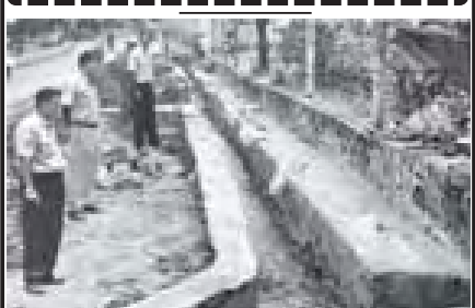
မိုးကုတ်မြို့နယ် စည်ပင်သာယာရေးအဖွဲ့က မြို့တွင်းရေစီးရေလာ ကောင်းမွန်ရေးအတွက် ဗိုလ်ချုပ်လမ်း ကျောက်စီရေမြောင်း ဆောင်ရွက်စဉ်၊ (မြို့နယ်စည်ပင်)
