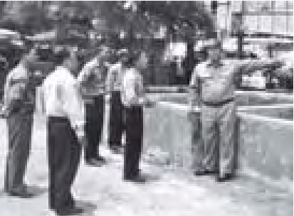
မော်လမြိုင်မြို့နယ် စည်ပင်သာယာရေးအဖွဲ့က ဈေးမီးဘေးကြိုတက်ကွယ်ရေးအတွက် ဆောင်ရွက်လျက်ရှိသော ဖြိုရဲရာနာလေးထပ်စော့ဂါလန် ၂၀၀၀၀ ဆုံ ရေစုကန်တည်ဆောက်ခြင်းကို မွန်မြည်နယ် စည်ပင်သာယာရေးအဖွဲ့၊ ညွှန်ကြားရေးမှူး ဦးအေးဆွေ တွင်းဆင်းစစ်ဆေးရာ အင်ဂျင်နီယာမှူး ဦးတင်ကိုကို ရှင်းလင်းတင်ပြနေပုံ။ (မြို့နယ်စည်ပင်)
