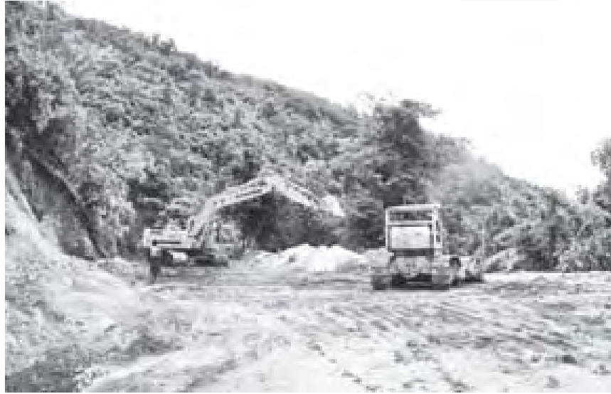
မြင်ဦးလွင်-မိုးကုတ်လမ်းကို ဤသို့ စက်ယန္တရားကြီးများဖြင့် ဆောင်ရွက်နေစဉ်။
