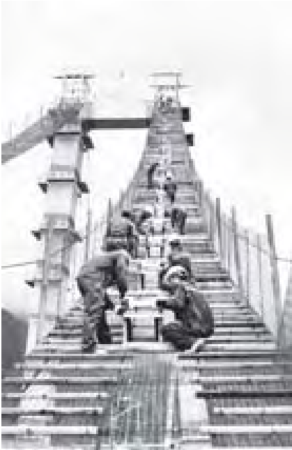
လိန်းလီကြီးတံတားကြီး၏ အဓိကကြိုးကြီးတပ်ဆင်ရန် ပြည်သူ့ဆောက်လုပ်ရေးလုပ်ငန်းမှ မြန်မာအင်ဂျင်နီယာ လုပ်သားကြီးများ ဆောင်ရွက်နေကြစဉ်။
