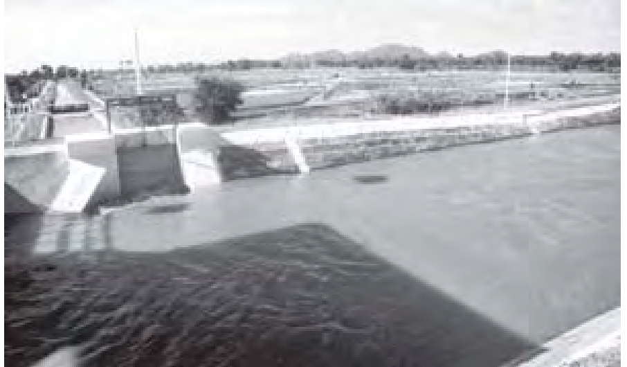
ဆားလင်းကြီးမြို့နယ် ကျောက်မျက်ကျေးရွာအနီးရှိ ညောင်ဝင်းကြီး လျှပ်စစ်မြစ်ရေတင်စီမံကိန်းကို တွေ့ရစဉ်။
