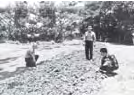
မိုးညိုမြို့နယ် စည်ပင်သာယာရေးအဖွဲ့က ၂၀၁၀-၂၀၁၁ ဘဏ္ဍာရေးနှစ် အတွက် မိုးညို-ဝဲကြီးလမ်း ဝင်ခင်းခြင်းလုပ်ငန်းကို ဇွန် ၅ ရက်က ဆောင်ရွက်ရာ အမှုဆောင်အရာရှိ ဦးအောင်မိုးသိန်းနှင့် တာဝန်ခံအင်ဂျင်နီယာ ဦးစိန်လှအောင်တို့ ကွင်းဆင်းကြည့်ရှု ဆောင်ရွက်စဉ်။
