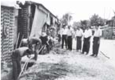
ရွှေတောင်မြို့ ရေဦးရေလာကောင်းမွန်နေအတွက် မြို့မဆေးပတ်လမ်း ရေနုတ် မြောင်းတူးဖော်ခြင်းကို အဖွဲ့ဝန်ထမ်းများဆောင်ရွက်ကြရာ မြို့နယ် စည်ပင်သာယာ ရေးအဖွဲ့ အမှုဆောင်အရာရှိ ဦးဟန်ရှိန် ကြီးကြပ်ဆောင်ရွက်စဉ်။ (မြို့နယ်စည်ပင်)
