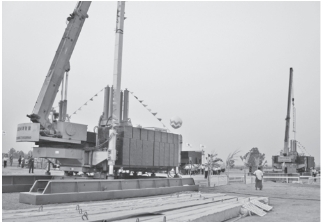
နေပြည်တော် အပြည်ပြည်ဆိုင်ရာလေဆိပ် တည်ဆောက်ရေး စီမံကိန်းလုပ်ငန်းခွင်တွင် လေဆိပ် အဆောက်အအုံ ပင်မဆောင် ဆောက်လုပ်ရန်အတွက် ပိုင်ရိုက်မှုတွေကို တွေ့ရရင်။
