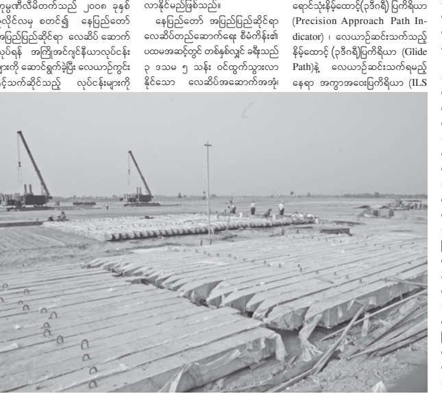
နေပြည်တော် အပြည်ပြည်ဆိုင်ရာလေဆိပ် တည်ဆောက်ရေးစီမံကိန်းလုပ်ငန်းခွင်၌ လေဆိပ်အဆောက်အအုံ ပင်မဆောင် ဆောက်လုပ်ရာတွင် အသုံးပြုမည့် ကွန်ကရစ် ပိုင်တိုင်များကို ဤသို့ ပုံသွင်းလောင်းပြုလုပ်ခဲ့သည်။
