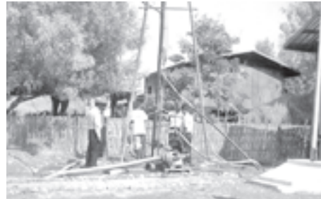
ကန်ဘလမြို့နယ် ထန်းတောကျေးရွာ အများသုံးစက်ရေကွင်း တူးဖော် ဆောင်ရွက်နေမှုအား ၈ ဧပြီ ၁ရက်က ကန်ဘလမြို့နယ် စည်ပင်သာယာရေးအဖွဲ့ အမှုဆောင်အရာရှိ လက်ထောက်ညွှန်ကြားရေးမှူး ဦးသစ်ထူးမြင့်နှင့် တာဝန်ခံ အင်ဂျင်နီယာ-၂ ဦးတို့က တွေ့ဆုံဆွဲနည်းကြည့်ရှုစစ်ဆေးခဲ့သည်။ (မြို့နယ်စည်ပင်)
