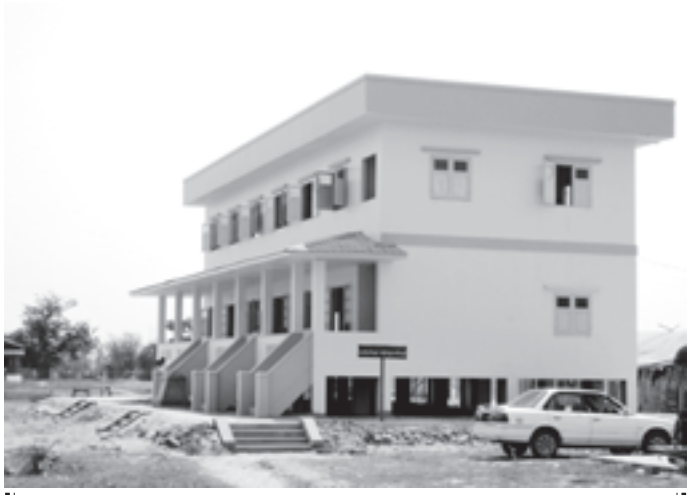
ကွမ်းခြံကုန်းမြို့နယ် သရက်သုံးပင်ကျေးရွာ၌ တည်ဆောက်ထားသော Cyclone Shelter အဆောက်အအုံကို တွေ့ရစဉ်။ (စွမ်းအင်)
