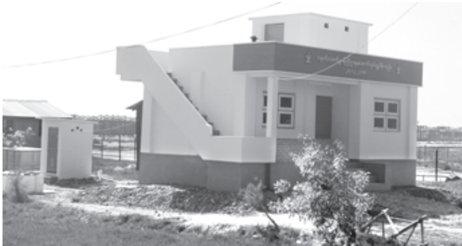
ပြင်စလူမြို့ရှိ အမှတ်(၁) စက်မှုဝန်ကြီးဌာနက ဆောက်လုပ်လှူဒါန်းသည့် Cyclone Shelter အဆောက်အအုံကို တွေ့ရစဉ်။ (သတင်းစဉ်)
