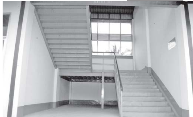
အတက်အဆင်း လျှောက်ကို STEEL ဖြင့် တည်ဆောက်ထားသည်ကို တွေ့ရစဉ်။
