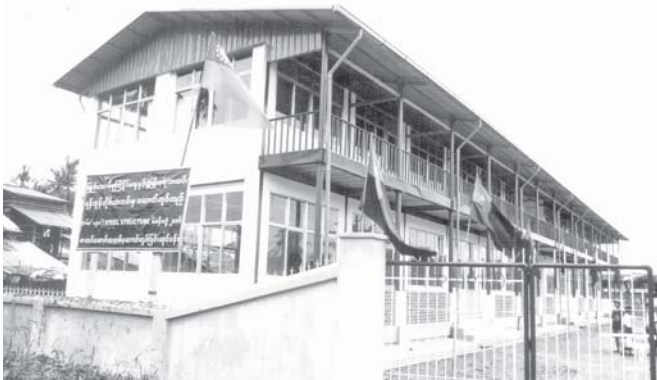
STEEL STRUCTUREဖြင့် တည်ဆောက်ထားသော ကျောင်းဆောင်သစ်ကြီးကို တွေ့ရစဉ်။
