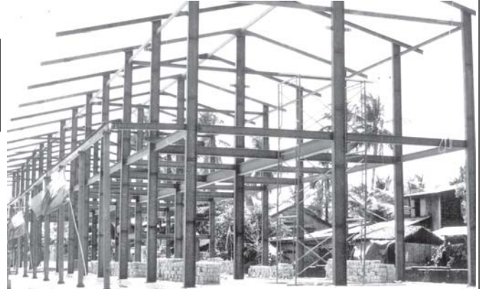
ကျောင်းဆောင်သစ်ကို STEEL STRUCTURE များဖြင့် စတင်တည်ဆောက်စဉ်။
