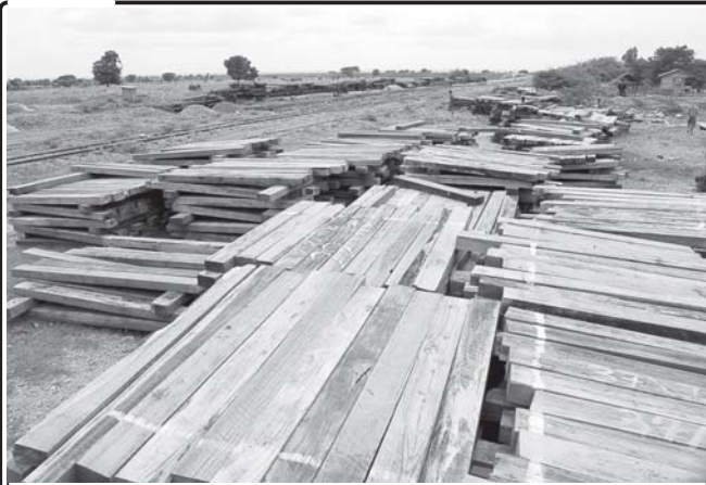
ရထားလမ်းသစ် ဖောက်လုပ်ရာတွင် အသုံးပြုမည့် လေဟာတုံးများကို တွေ့ရစဉ်။
