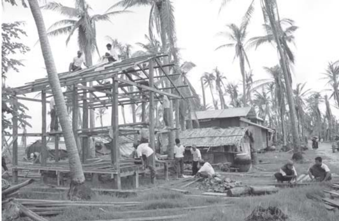
သင်္ကန်းလေးကျေးရွာရှိ မုန့်တိုင်းဒဏ်ကြောင့် ပျက်စီးသွားသောနေထိုင်မှုများကို ပြည်ထောင်စုကြံ့ခိုင်ရေးနှင့် ဖွံ့ဖြိုးရေးအသင်းဝင်လူငယ်များ ပြန်လည်တည်ဆောက်ပေးနေစဉ်။
