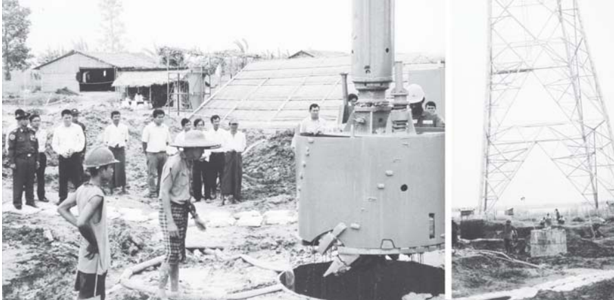
အမှတ်(၂) လျှပ်စစ်စွမ်းအားဝန်ကြီးဌာန ဝန်ကြီး ဗိုလ်ချုပ်စင်မောင်မြင့် ဧရာဝတီတိုင်း ပန်းတနော်မြို့နယ် ကလေးတောကျေးရွာအနီး ဧရာဝတီမြစ်ကျော် 230 KV မဟာဓာတ်အားလိုင်း တာဝါတိုင် အမှတ်(T-147) တိုင်သစ် တည်ဆောက်မှု လုပ်ငန်းများကို ကြည်စွမ်းဆောင်ရည် (အမှတ်-၂ လျှပ်စစ်)
