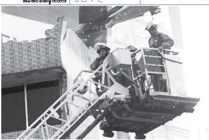
ပန်းမားနိုင်ငံ ပန်းမားစီးတီးမြို့ ရဟတ်ယာဉ် ပျက်ကျရာနေရာရှိ မီးလောင်နေသော အဆောက်အအုံကို ဖိုဗျီးသတ်ရန် ကြိုးစားနေကြသော မီးသတ်သမားများအား ဖေ ၂၉ ရက်က တွေ့ရစဉ်။ (ဓာတ်ပုံ-အင်တာနက်)
