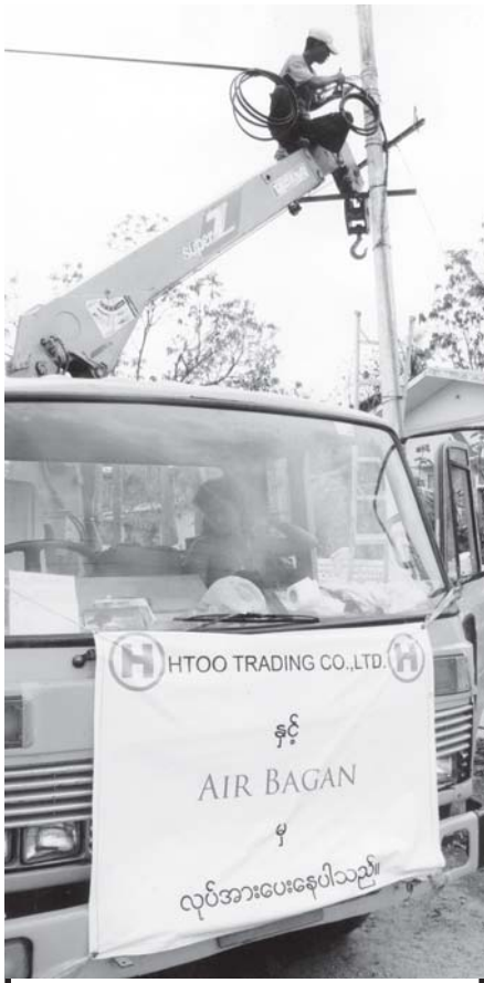
Htoo Trading Co., Ltd. နှင့် Air Bagan Co., Ltd မှ စက်ယန္တရားများဖြင့် အမှတ်(၂) လျှပ်စစ်စွမ်းအားဝန်ကြီးဌာနမှ ဝန်ထမ်းများ ပူးပေါင်း၍ ဘိုကလေးမြို့နယ်တွင် လျှပ်စစ်မီးတိုင်းများ ပြန်လည်ဖြူမြင်တပ်ဆင်နေစဉ်။ (ကြေးမုံ)
