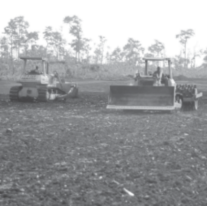
ရပ်စောက်မြို့နယ်ရှိ ကျိုင်းခမ်း ရေလှောင်တံစဲတွင် စက်ယန္တရား များ အသုံးပြု၍ လုပ်ငန်းဆောင်ရွက်နေမှုကို တွေ့ရစဉ်။ (သတင်းစဉ်)
